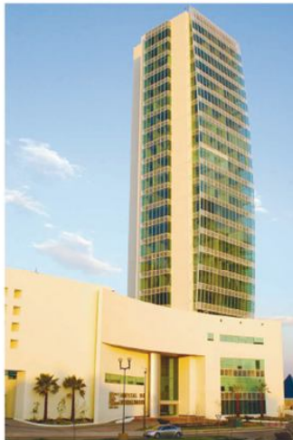
Hospital de Especialidades Centro Médico Puerta de Hierro 2006.
